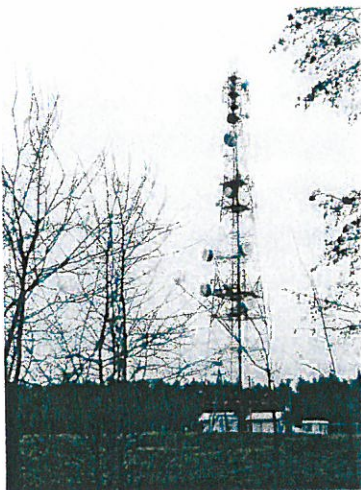
Zdjęcie 16 Stacja przekaźnikowa w Objezierzu
