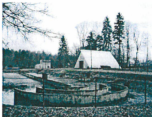
Zdjęcie 15 Oczyszczalnia ścieków w Zielinie
