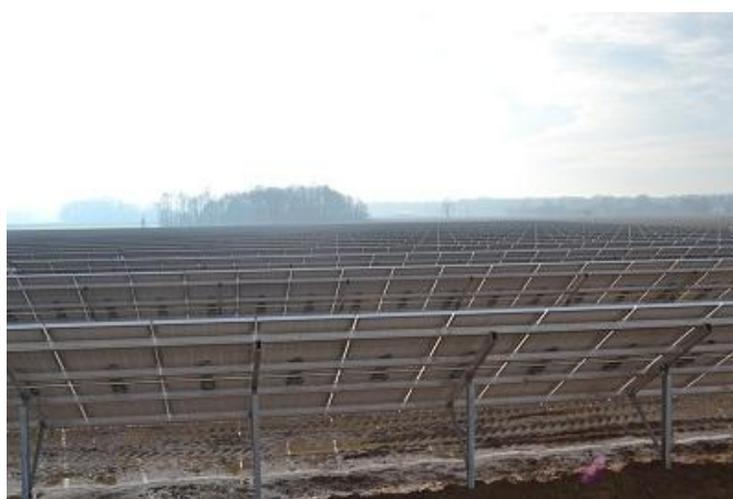
Fot.3. Etapie budowy – montaż paneli ( http://gramwzielone.pl/ )
