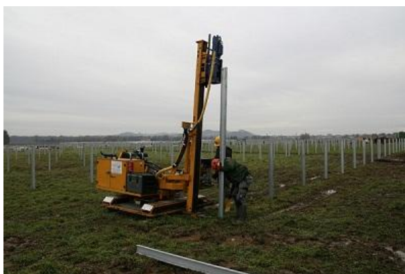
Fot. 1. Etap budowy – wbijanie pionowych podpór ( http://gramwzielone.pl/ )
