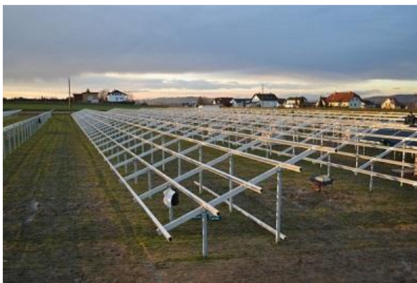
Fot. 2. Etap budowy – montaż poprzecznych wsporników ( http://gramwzielone.pl/ )
